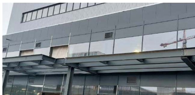
GRIDX Luxembourg - Maître d'ouvrage : Félix Giorgetti - Mise en oeuvre : Groven + Portal
